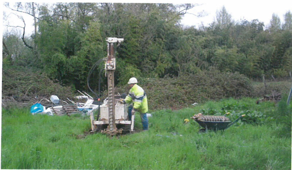
Figure n°11 : Réalisation du sondage S5.
