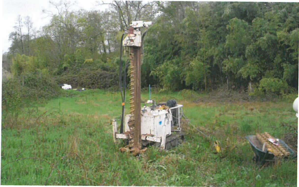
Figure n°10 : Réalisation du sondage F4.
